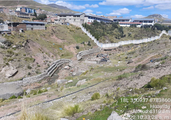
Fotografía 1: Deslizamiento del talud, de los muros tipo gavión en el rio San Jose en el sector Huayllay.
