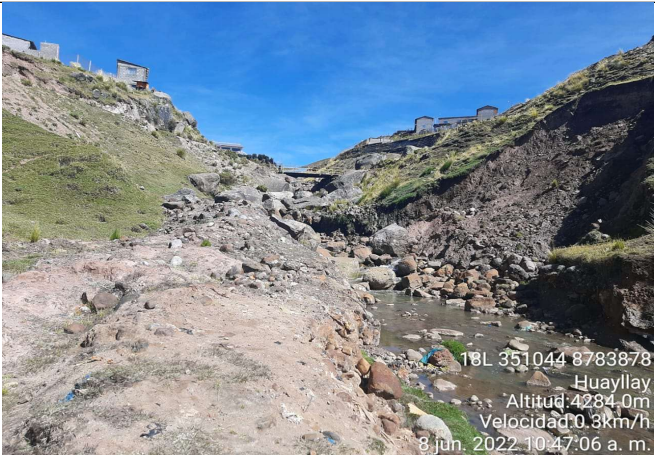
Fotografía 4: Colmatacion, deslizamiento y exposicion a la socavacion del talud ambas margenes del cauce del rio San Jose en el sector Huayllay
